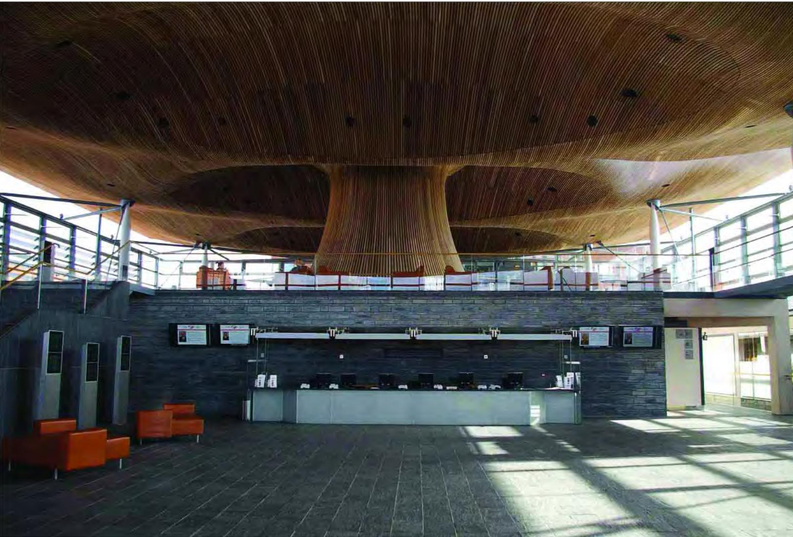
Une toiture légère et ondoyante couvre les espaces intérieurs et extérieurs et forme une sorte « d'entonnoir » au-dessus de la Chambre des débats. Cette forme, qui est au cœur de l'approche bioclimatique du projet, possède deux fonctions : laisser entrer la lumière naturelle et ventiler la Chambre en contrebas.
